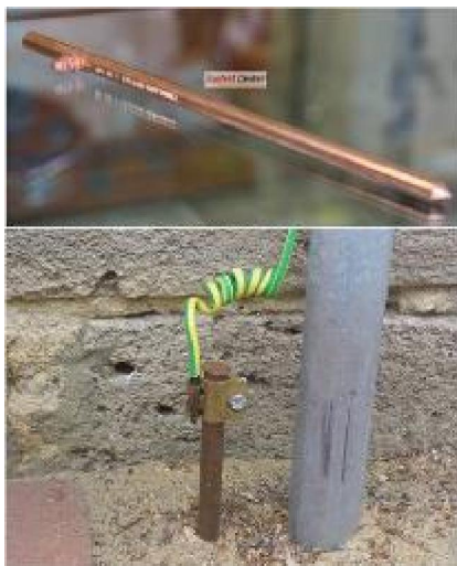
ภาพสายดินและหลักดิน
