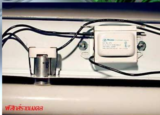
ภาพที่ 1-5 การต่อสตาร์ทเตอร์เข้ากับบัลลัสต์
