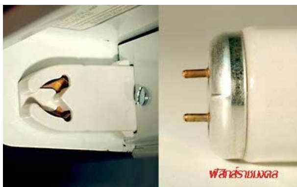
ภาพที่ 1-5 แสดงการสวมหัวหลอดเข้าไปในจาดู
